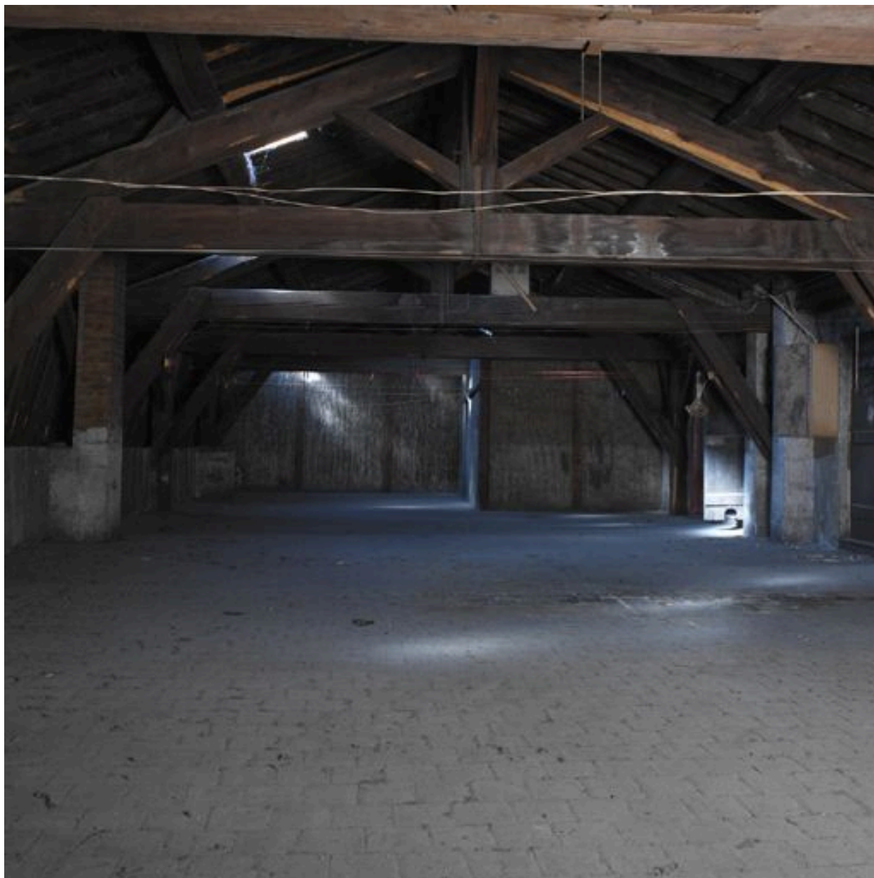
Vue d'ensemble de la charpente du corps de bâtiment sud
