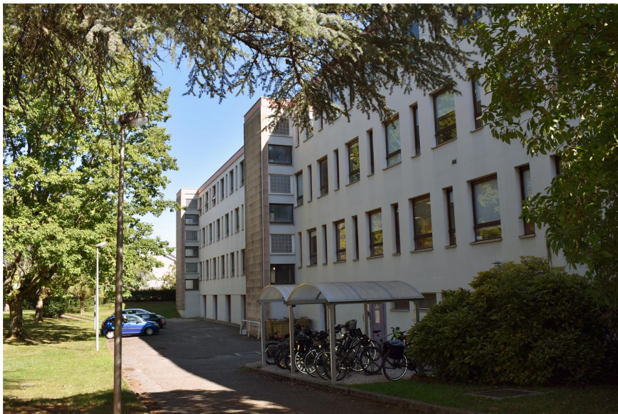
Bâtiment A : élévation postérieure depuis le sud
