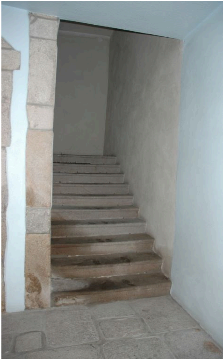
Départ de l'escalier avec mur noyau.
