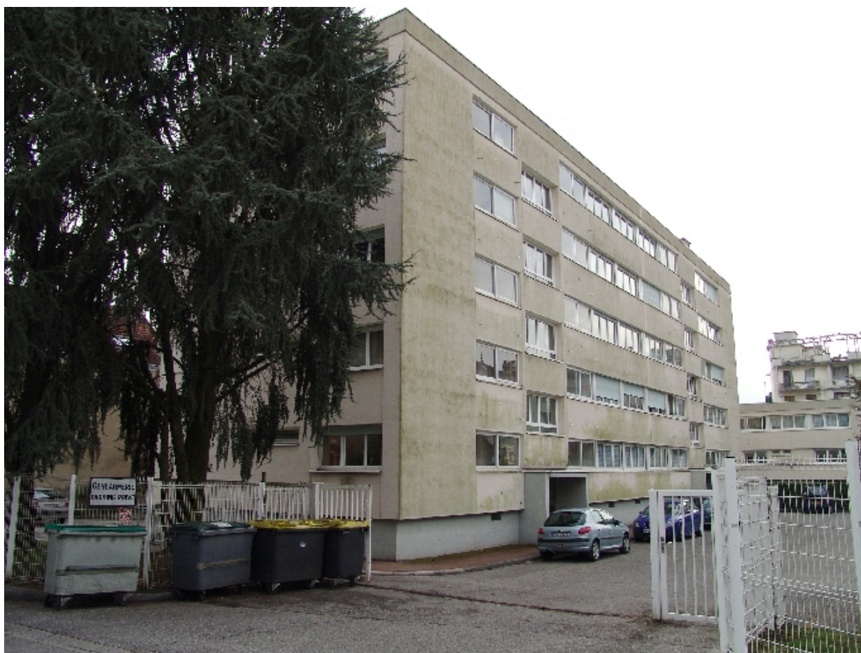
Vue du bâtiment postérieur
