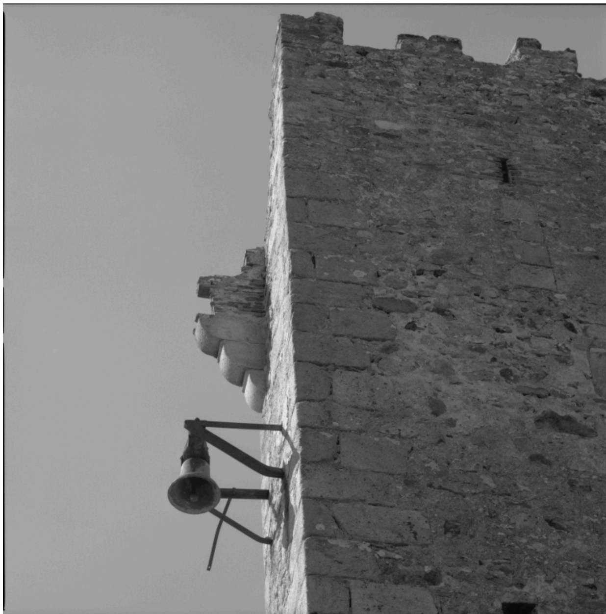
Ouvrage d'entrée, mur nord-est : détail extérieur d'une console de mâchicoulis, du nord-ouest.
