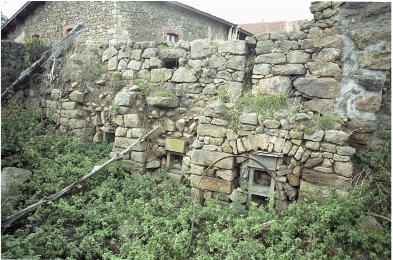
Ferme à Eculieux (B4 986), vue partielle de l'intérieur de l'étable en ruine.
