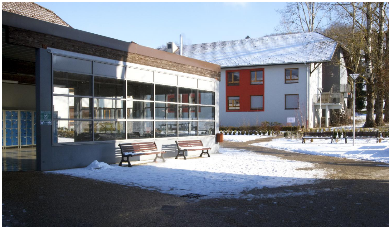
Vue d'ensemble vers l'ouest, depuis l'entrée du lycée
