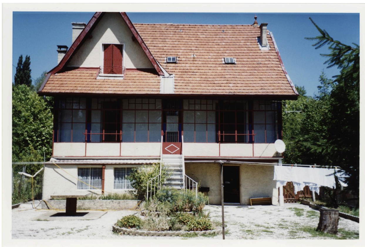
Façade postérieure. Photogr. 2003
