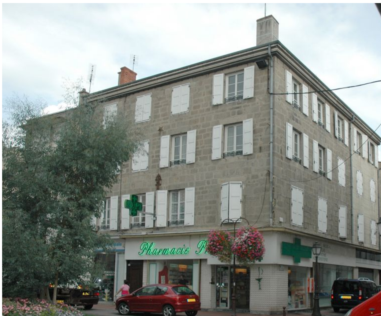
Vue de trois-quarts depuis la rue Tupinerie.
