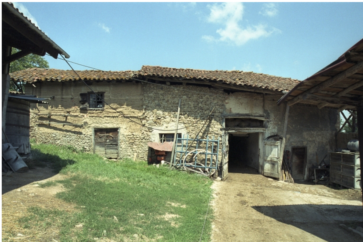
Marcoux, Goutterelle (1986 ZE 37), type A2. Vue d'ensemble de la ferme originelle, depuis la cour.
