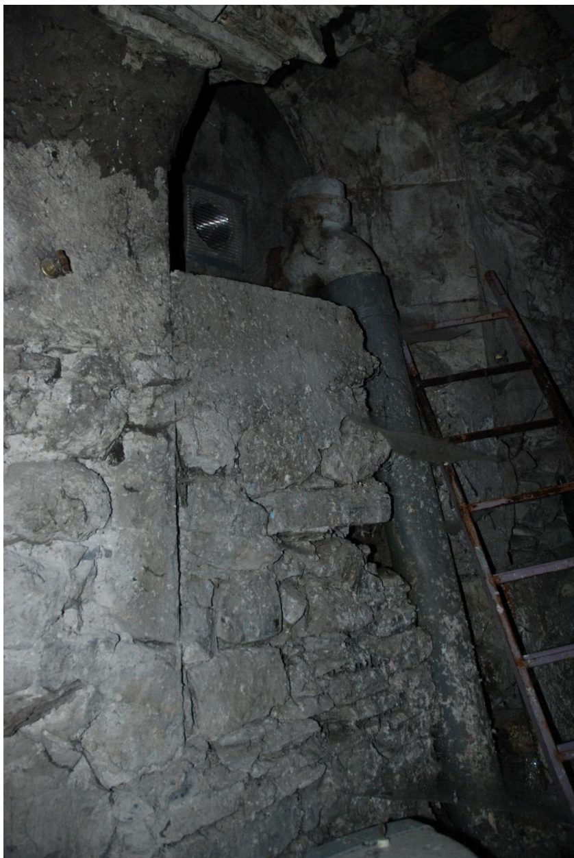
Vue extérieure des vestiges du collatéral est, mur est : 2e fenêtre (murée).
