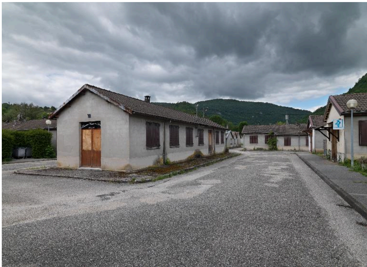
Vue de la cité Dortan : ancienne mairie
