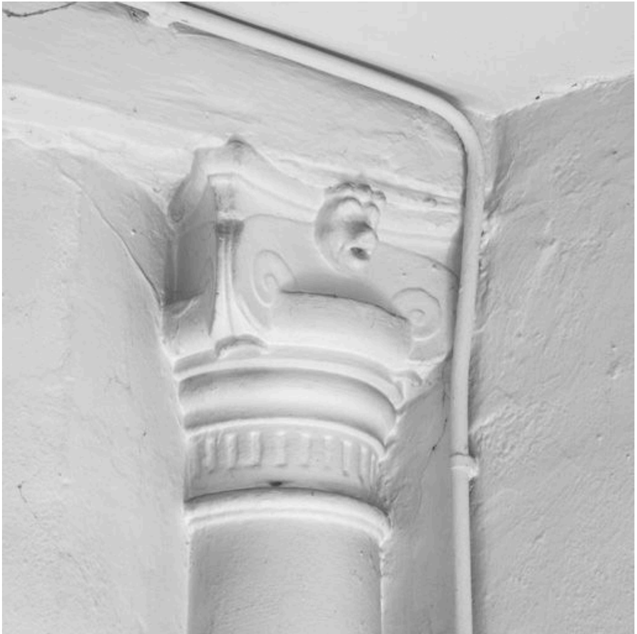
Corps de bâtiment nord. Détail du chapiteau de la colonne engagée
