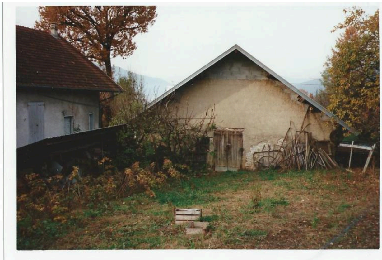
Pignon sud de la grange avant transformation, 1998
