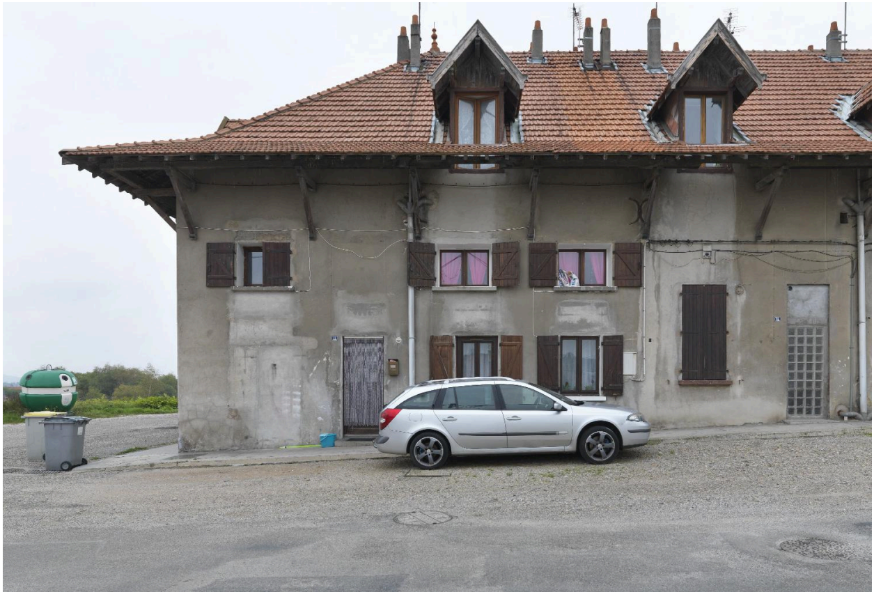
travée Nord du bâtiment du Réveil
