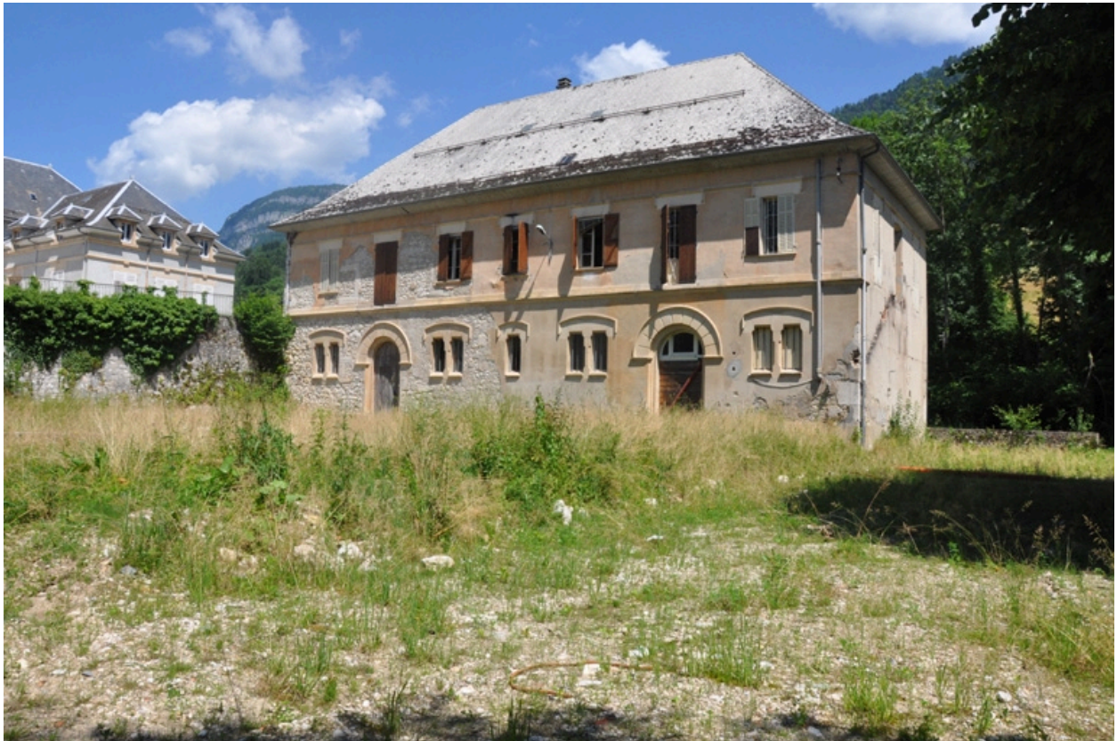
Vue de la façade ouest du bâtiment des soins
