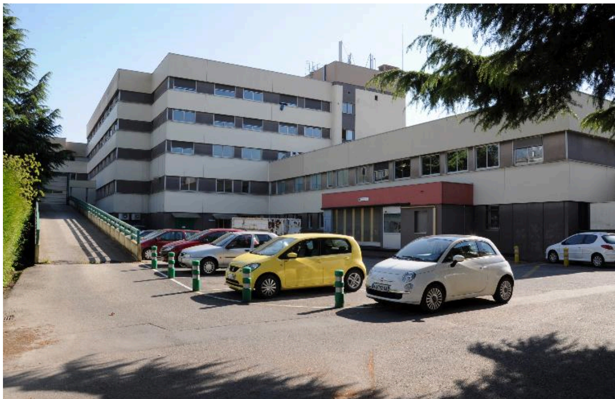
Vue depuis l'arrière
