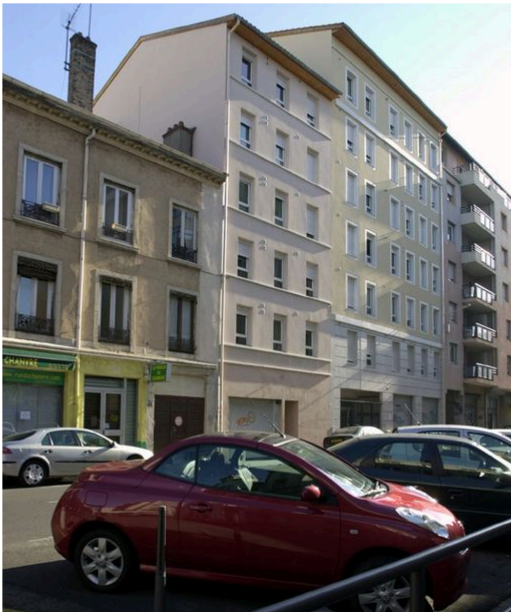
Elévation antérieure depuis le sud-ouest
