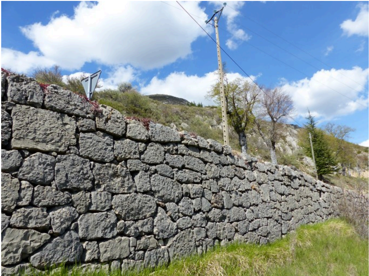
Ancien chemin au-dessus du quartier du Génisseau, mur de soutènement.
