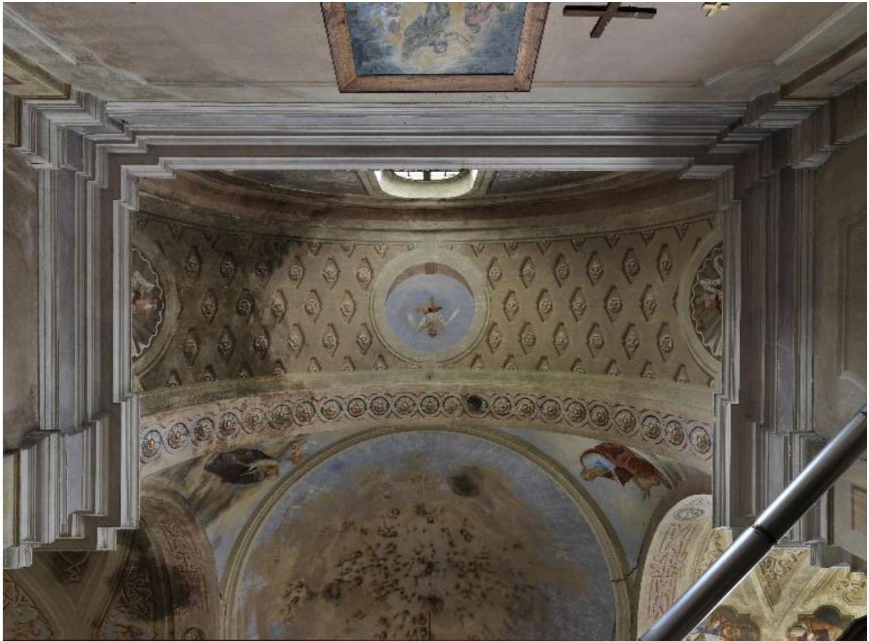
Vue de la voûte de la chapelle nord.
