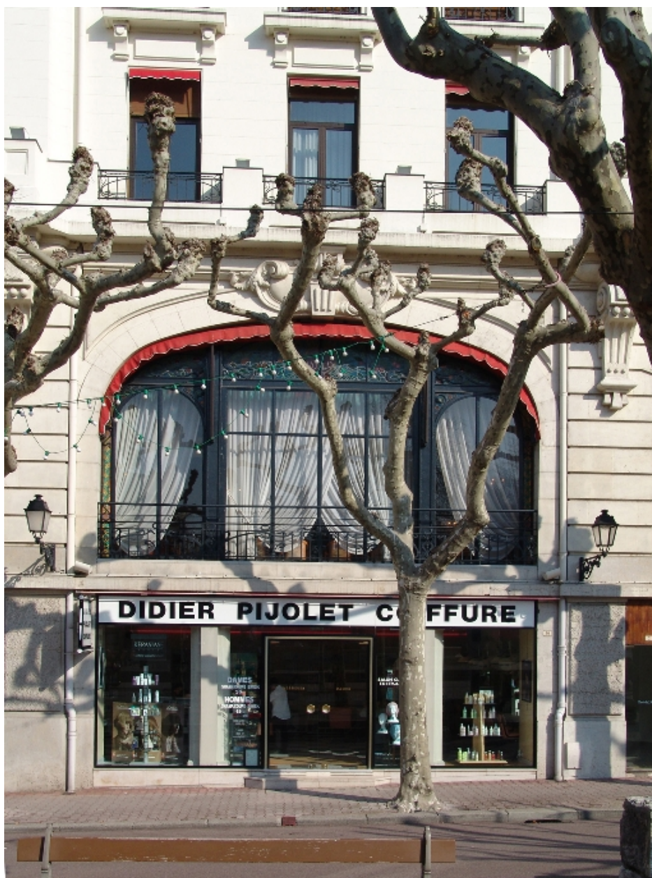
Détail de la façade sud
