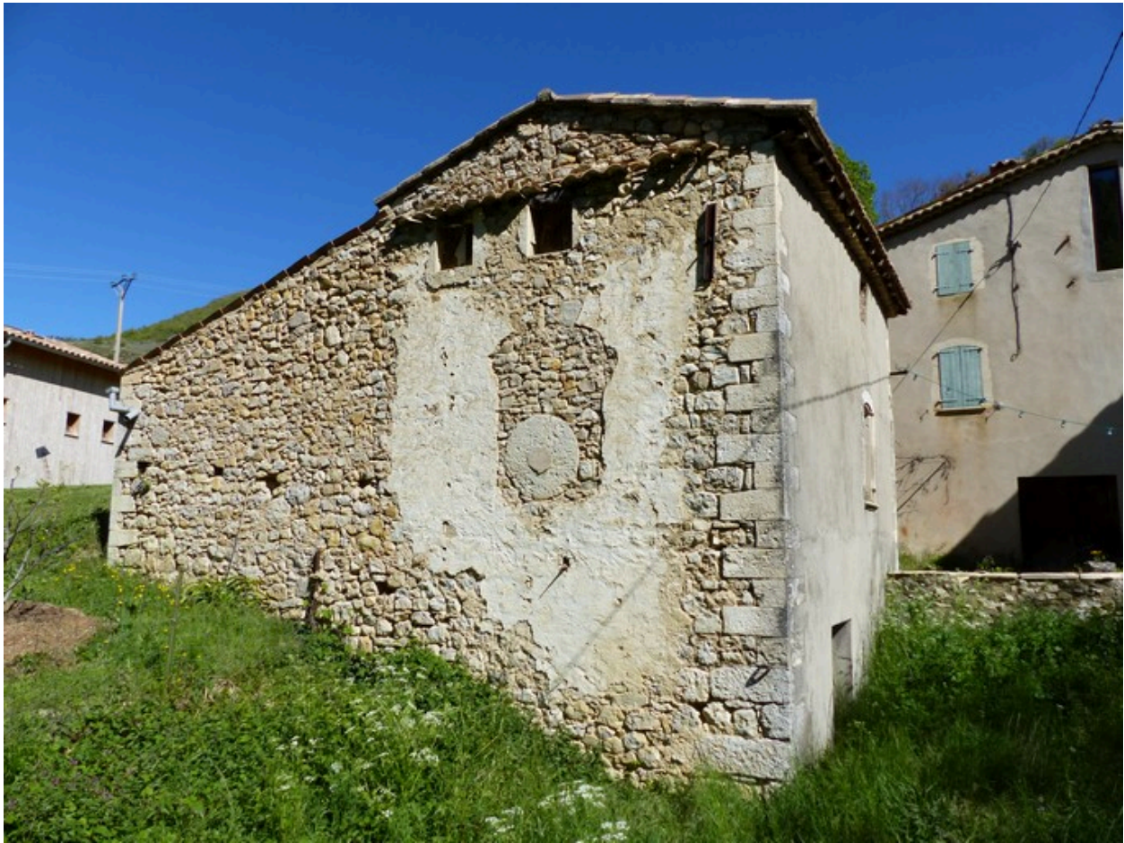
Dépendance sud-ouest. Pignon sud.
