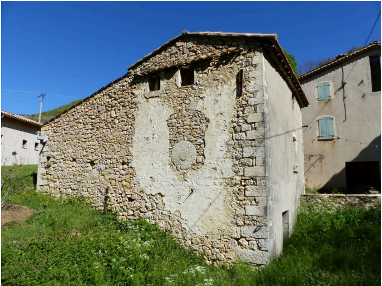
Dépendance sud-ouest. Pignon sud.
