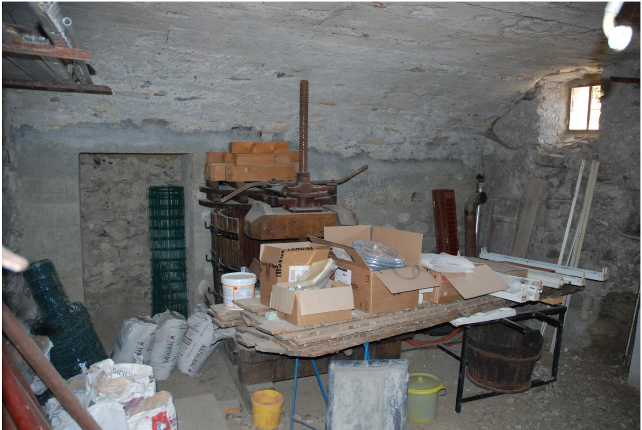
Ferme (2018 H2 543 à 547). Habitation (543), vue intérieure d'une cave.
