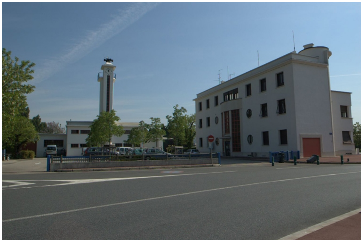
Bâtiment administratif vue nord-est
