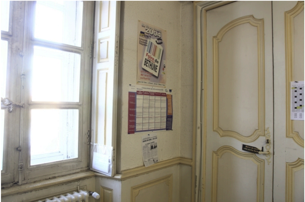
Bâtiment A, 1er étage. Greta. Bureaux sur l'aile orientale.
