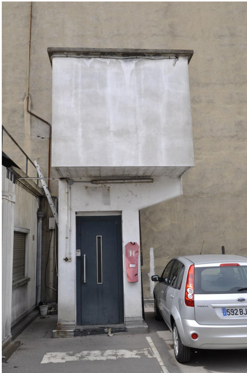
Détail de la porte de l'ascenseur desservant le parking extérieur
