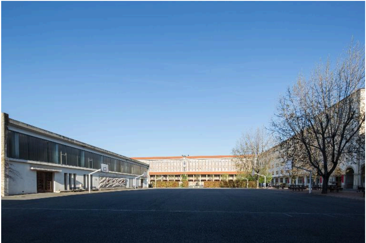
Cour intérieure : à gauche le gymnase, au fond bâtiment A, à droite bâtiment B
