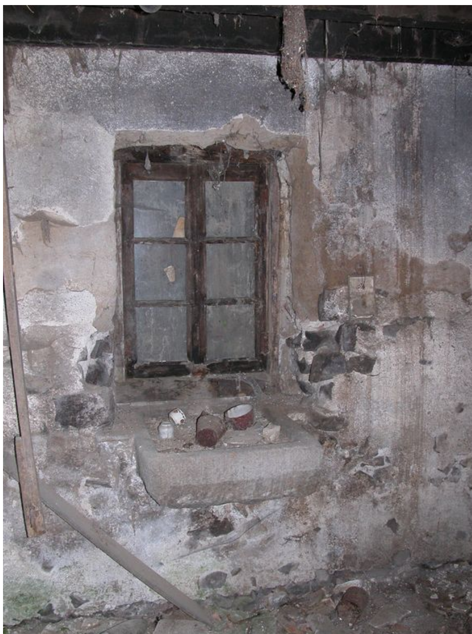
Vue intérieure du cellier : fenêtre avec évier.
