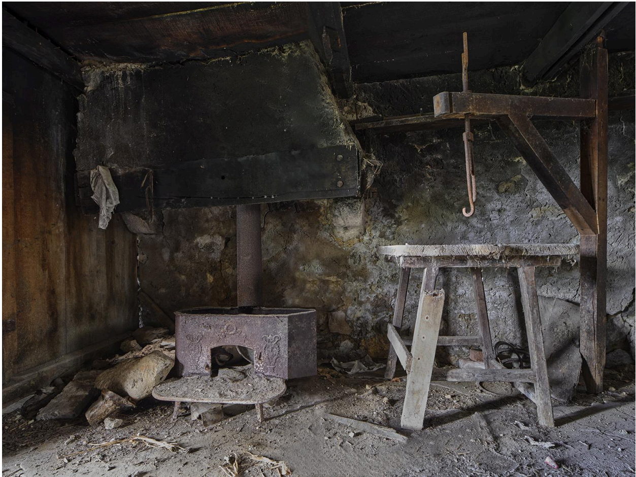
Vue de la cheminée et de la potence contre le mur maçonné.
