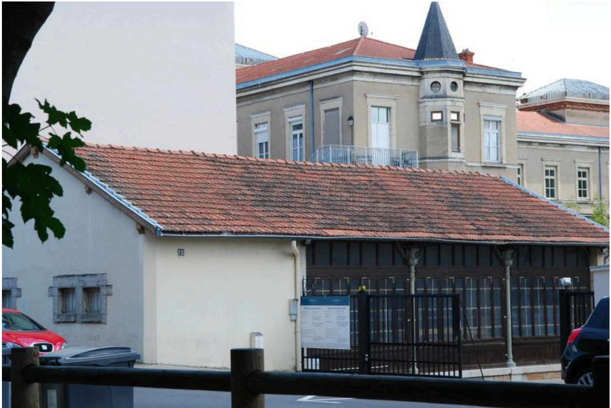
Détail d'un bâtiment annexe.
