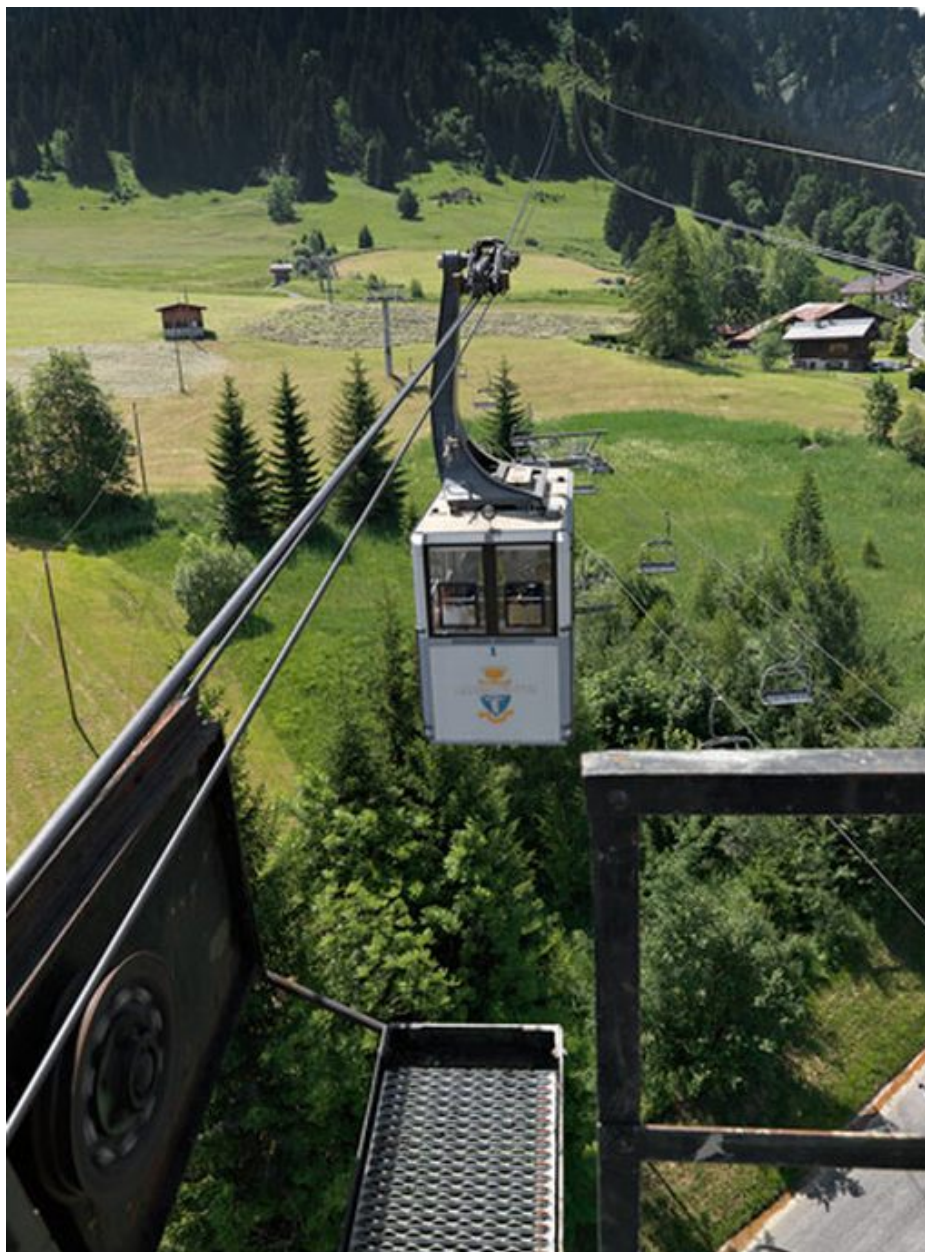
La cabine arrivant pour le passage du pylône
