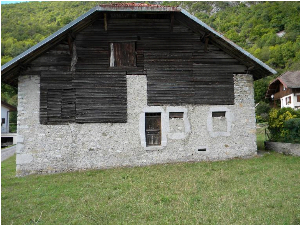
Vue de la façade principale (façade est)
