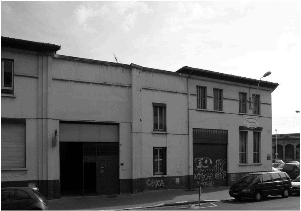
Façade ouest, immeuble d'origine
