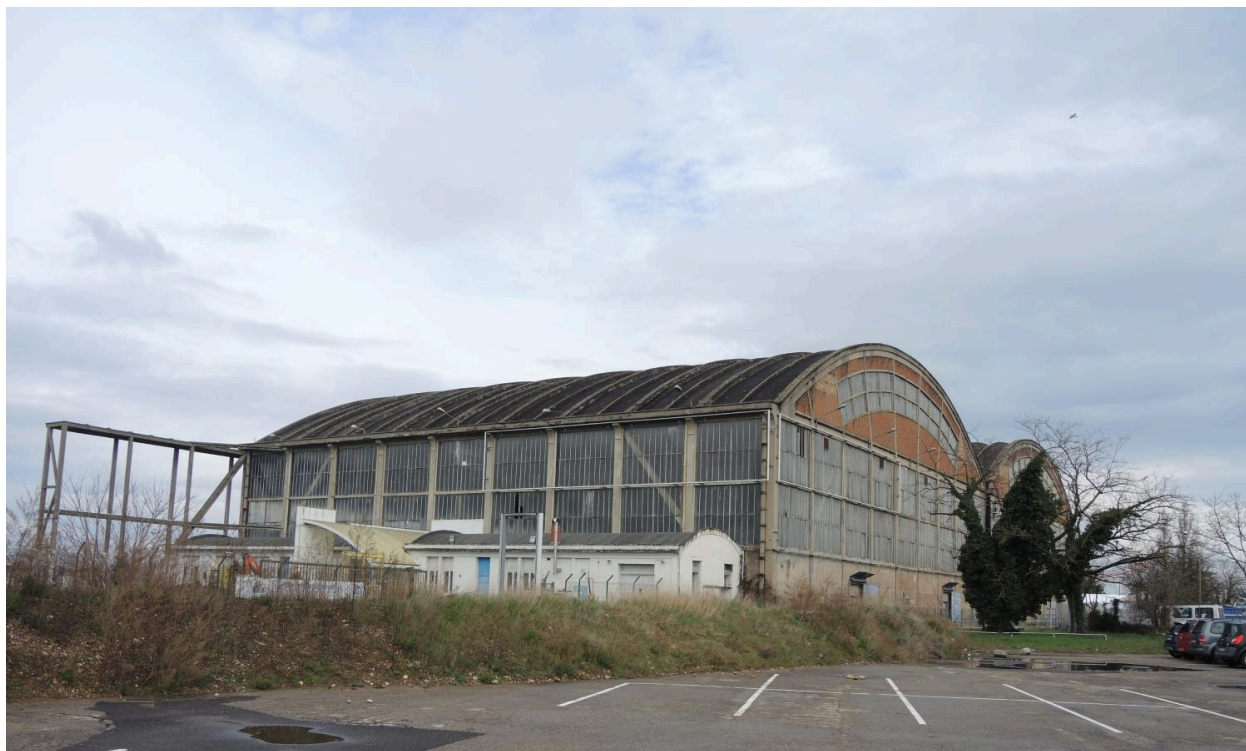
Hangar VI photo vue d'extérieur
