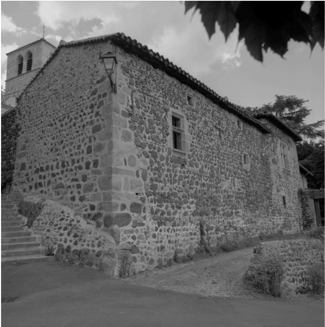
Vue générale de la façade sur rue, de trois-quarts.
