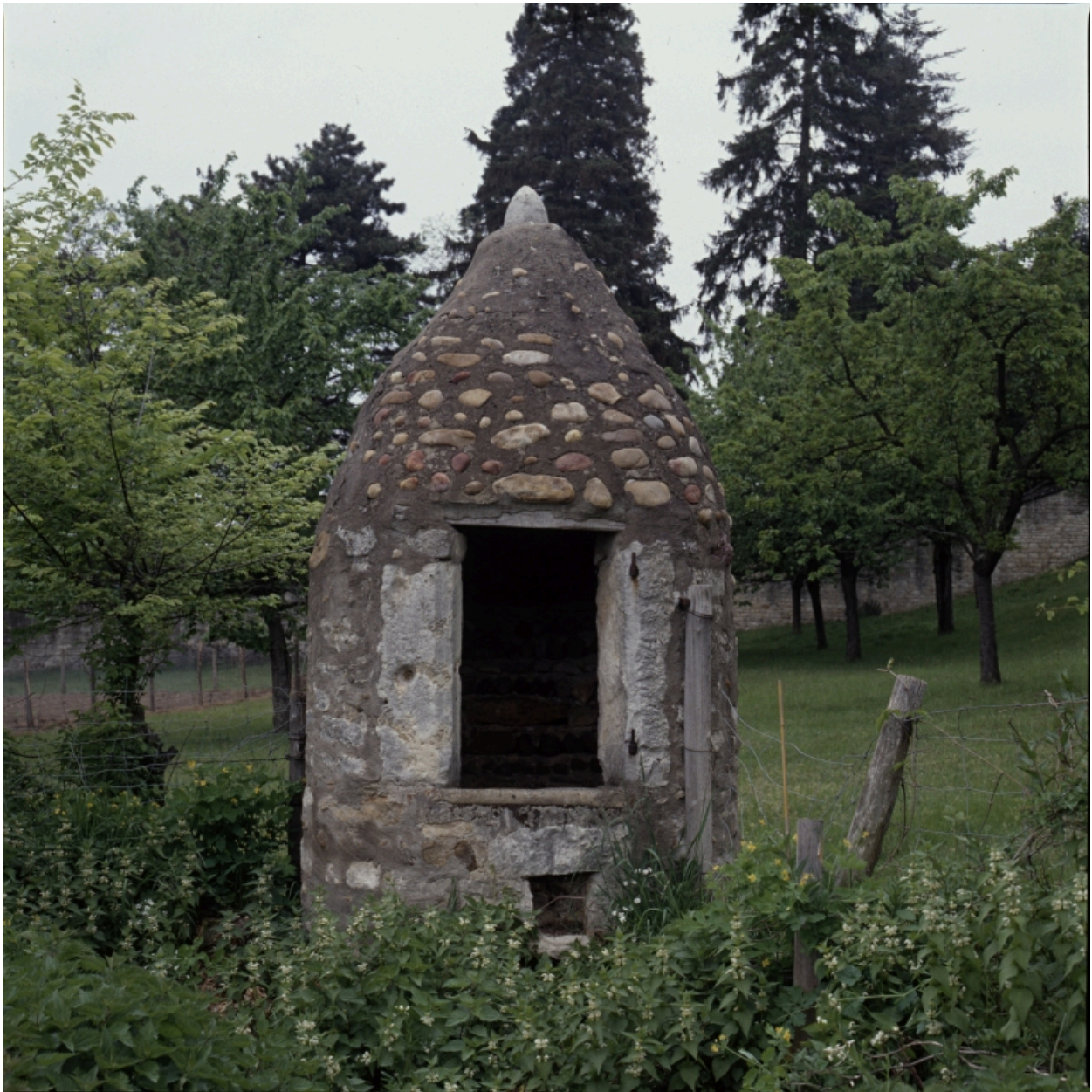
Puits extérieur couvert en dôme.
