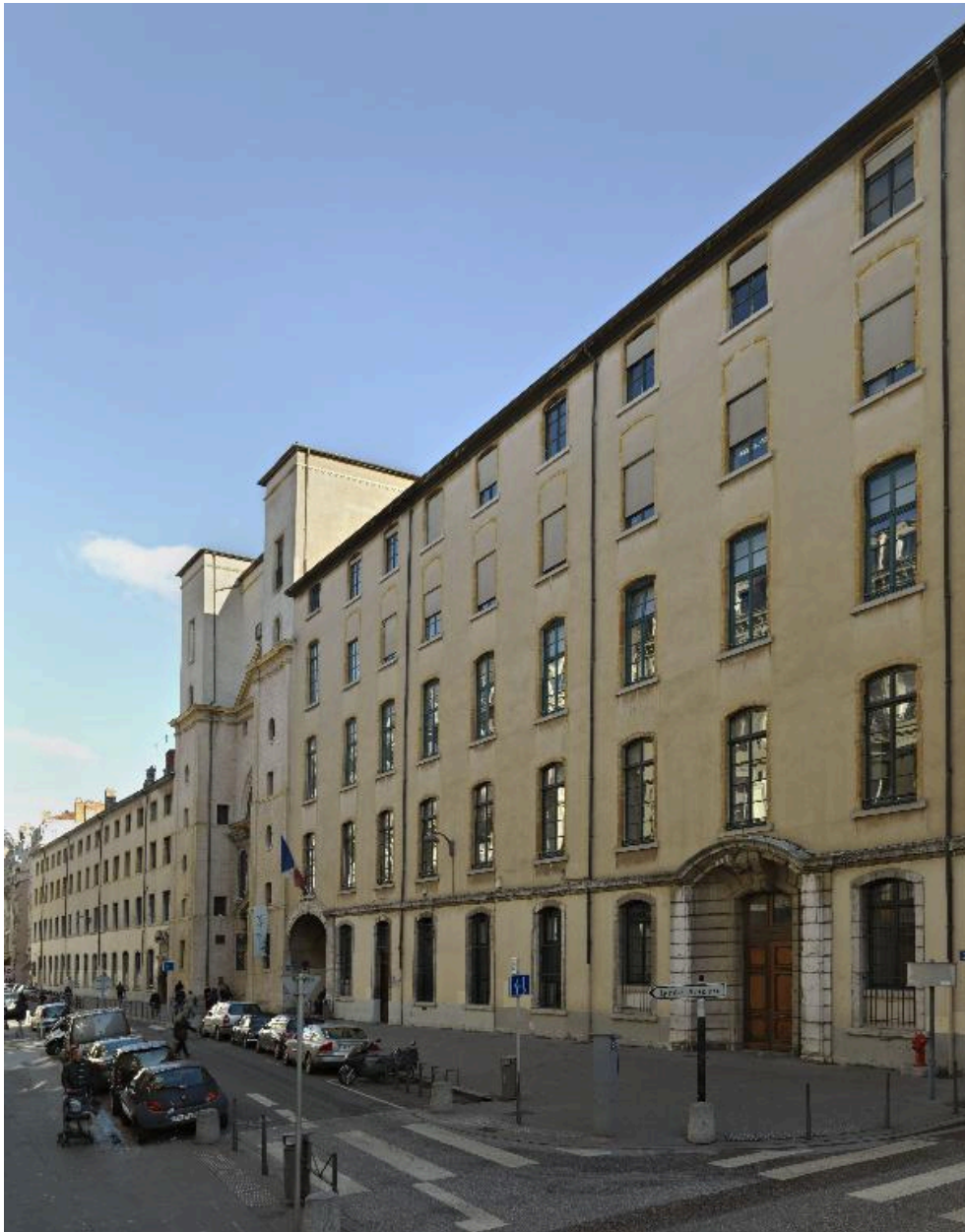
Élévation principale, vue d'ensemble depuis le sud-ouest
