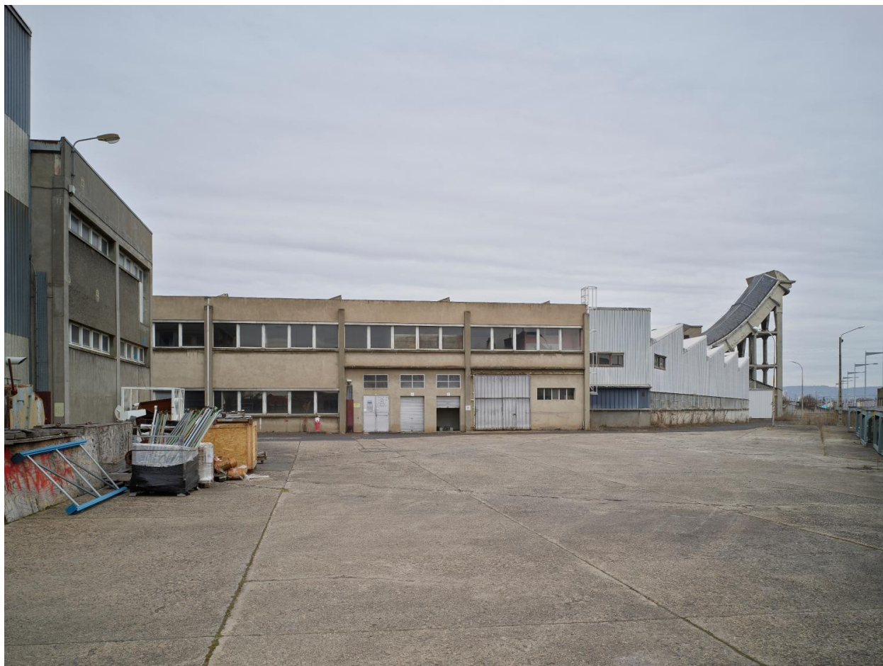
Les ateliers O26 depuis le sud. Sur la droite à l'arrière-plan, l'extrémité de l'une des pistes d'essais.
