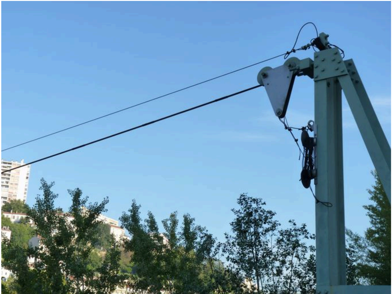
Détail de la structure métallique subsistante en rive gauche
