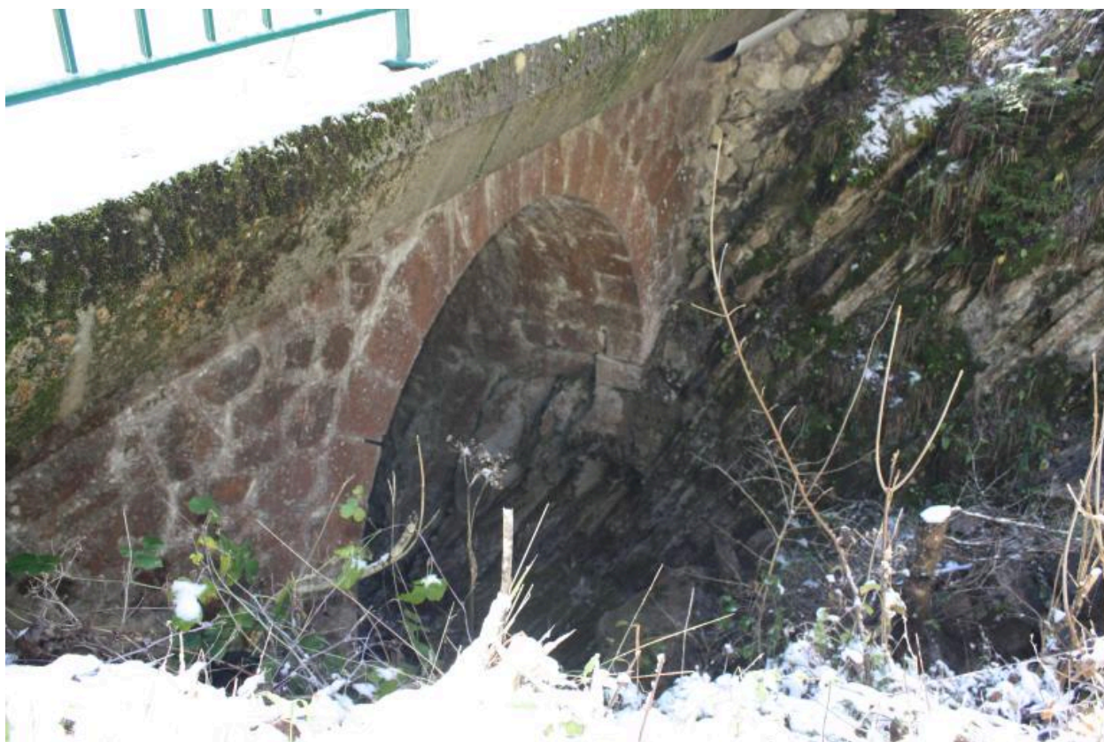
Pont des Granges, détails route, culée et plinthe
