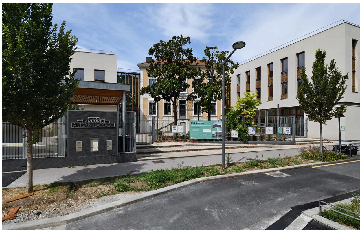
Rue des Docks, vue générale, état en 2025
