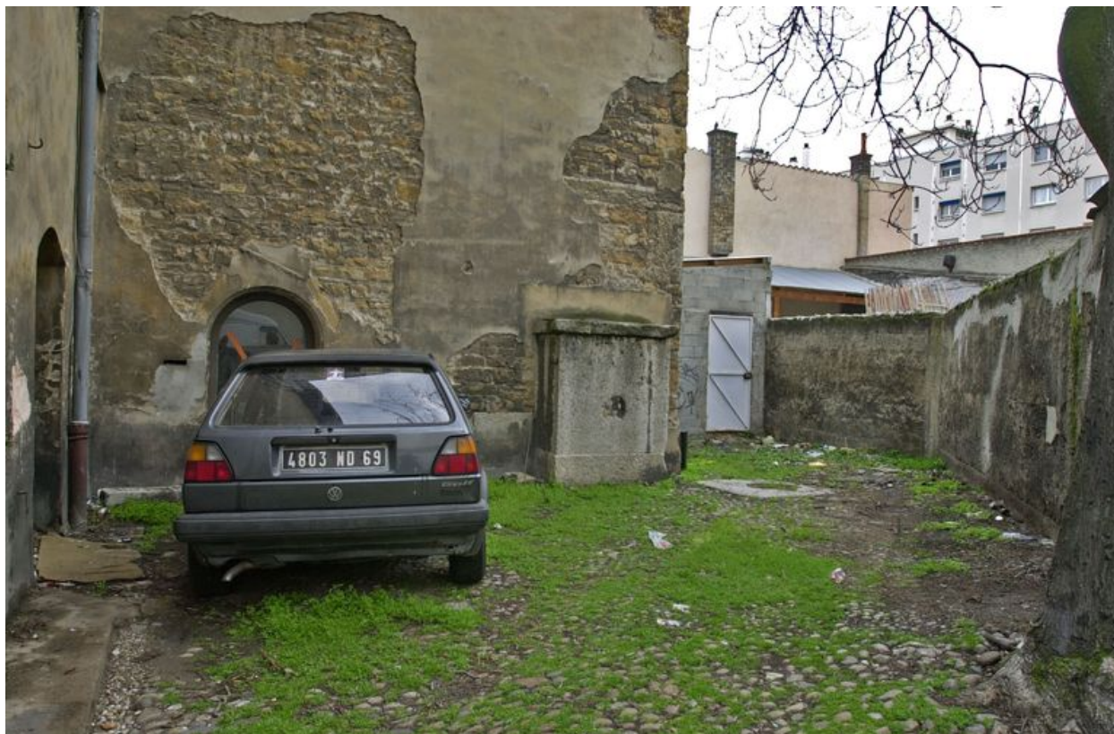
Partie inférieure du mur pignon sud sur cour
