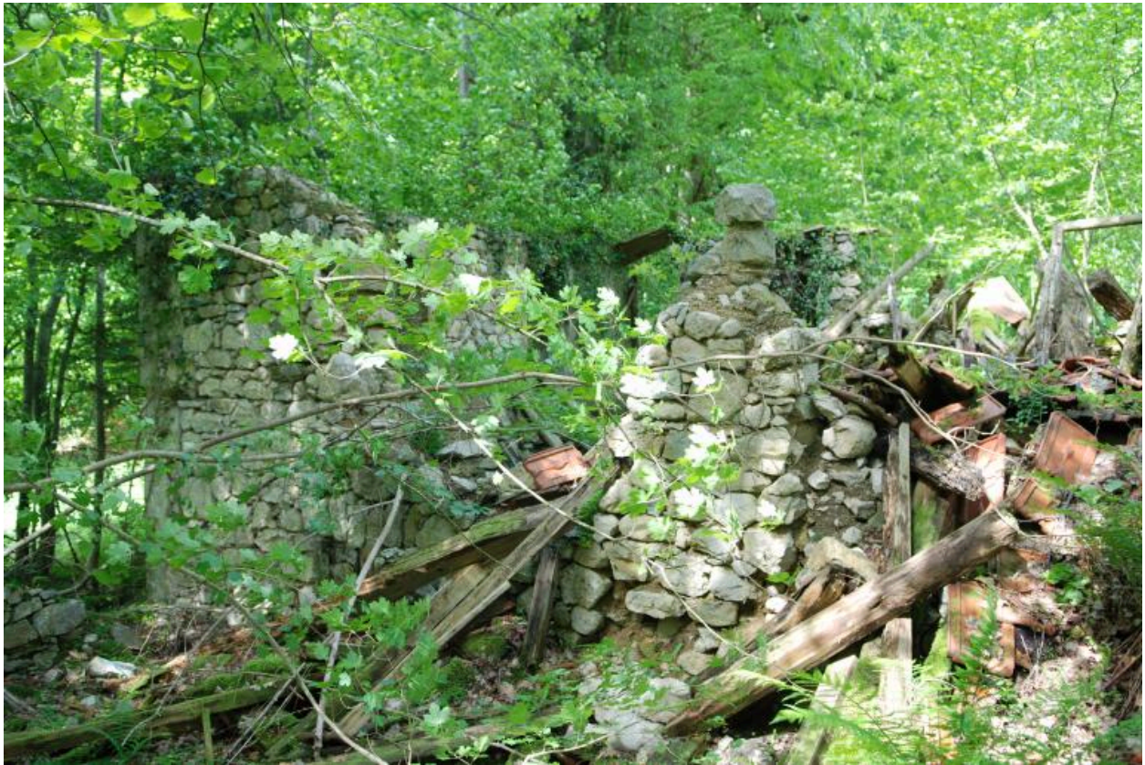
D2 177 à 179, Foyères-Sud (les), ferme. Vue d'ensemble des ruines
