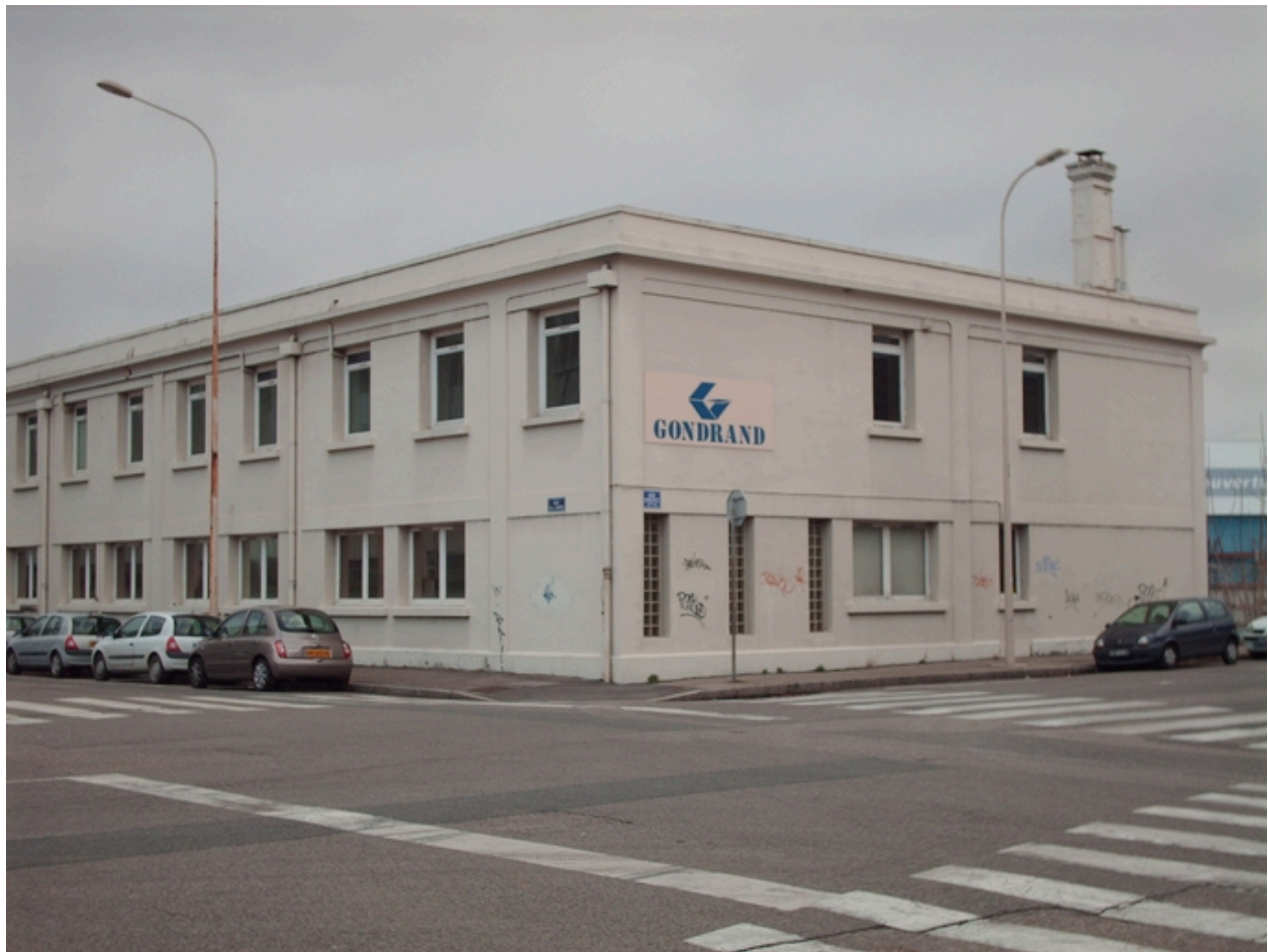
Bâtiment administratif de la sté Gondrant
