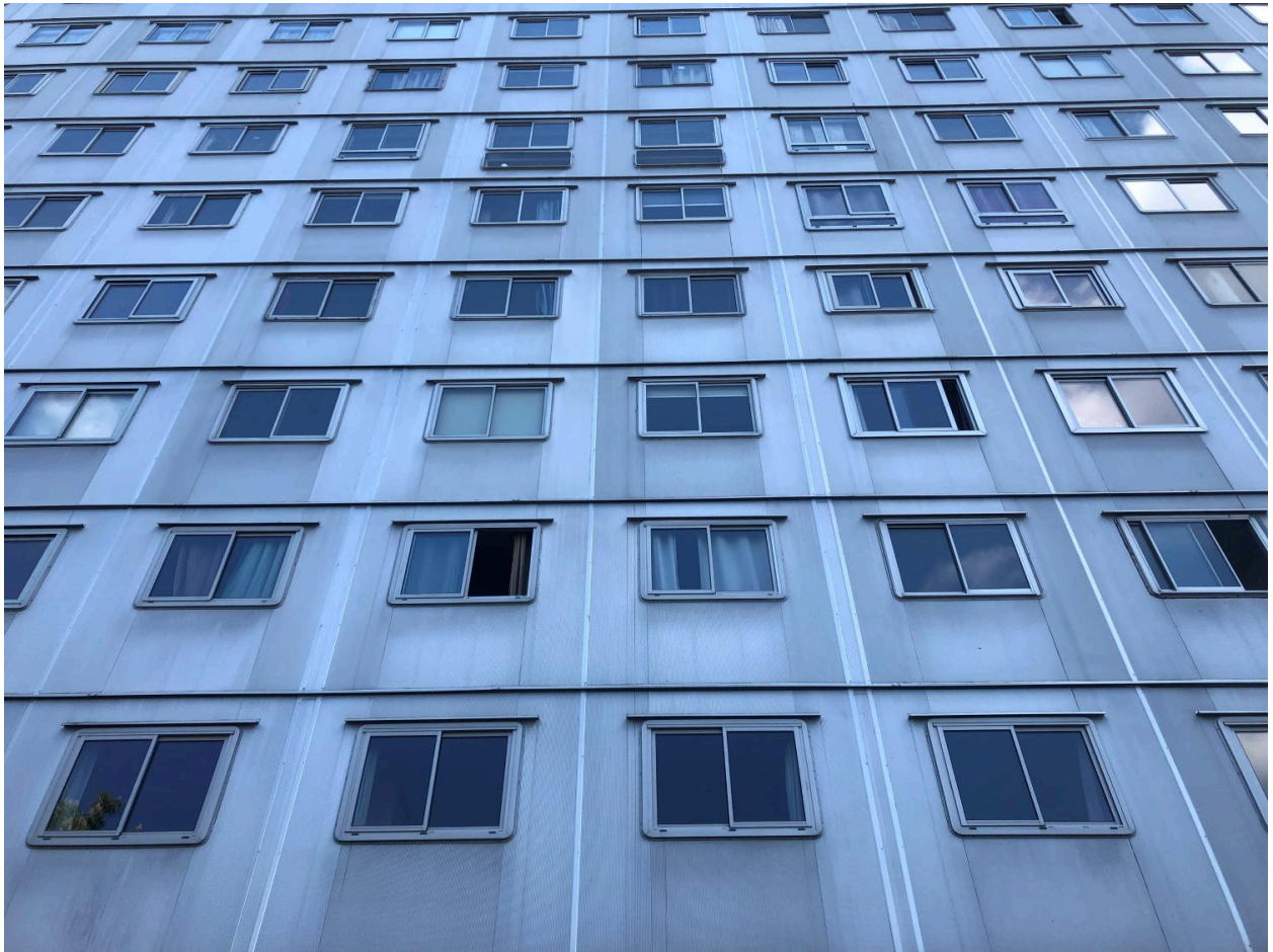
Façade nord (arrière de l'immeuble des Cèdres)
