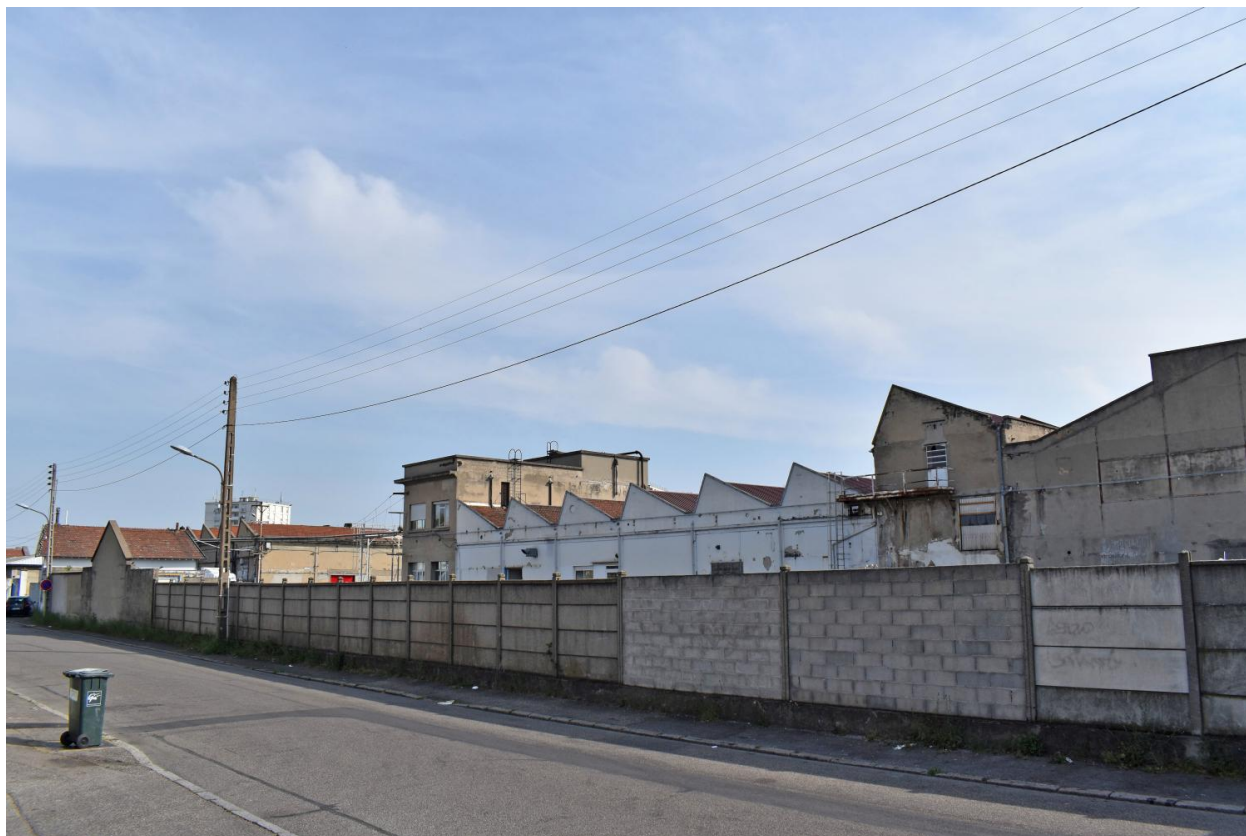
Usine Chimiotecnica - vue depuis la rue de l'industrie
