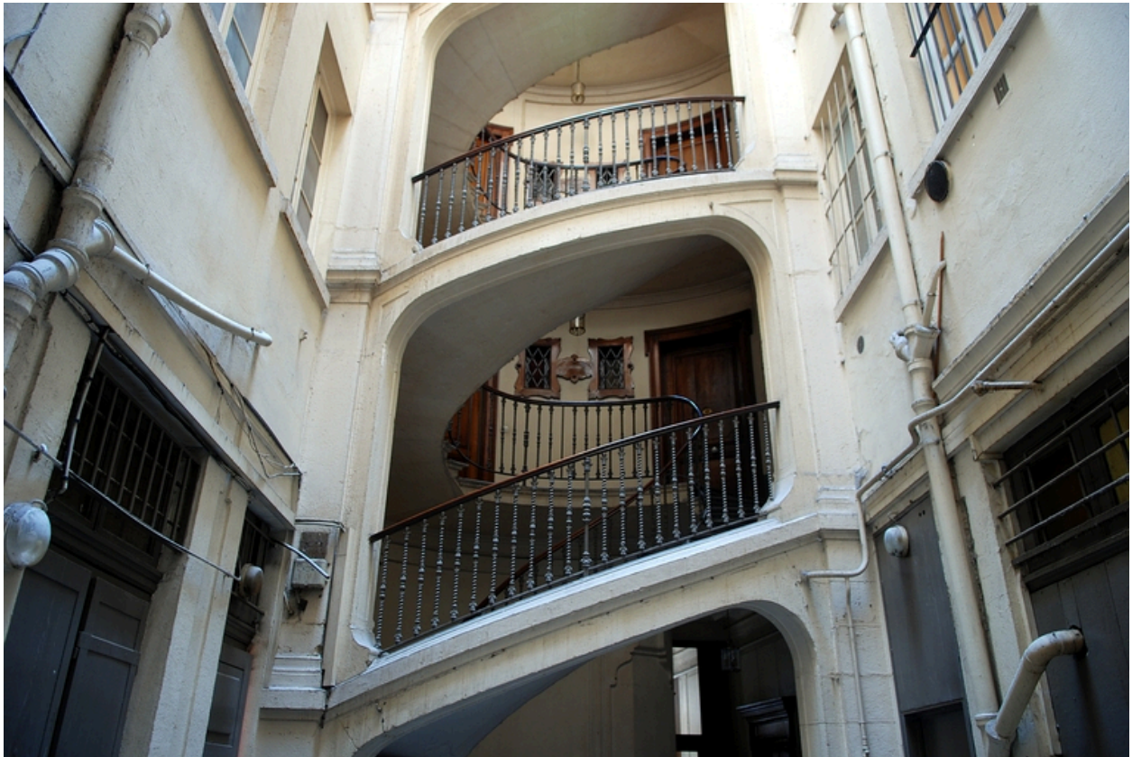
Escalier est : détail de deux volées
