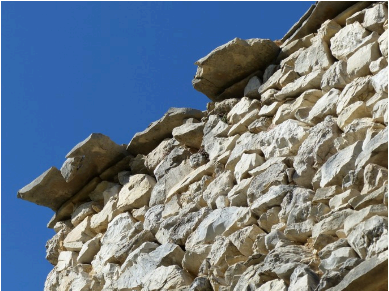
Avant-toit constitué d'un débord de lauzes, entrepôt agricole au village.
