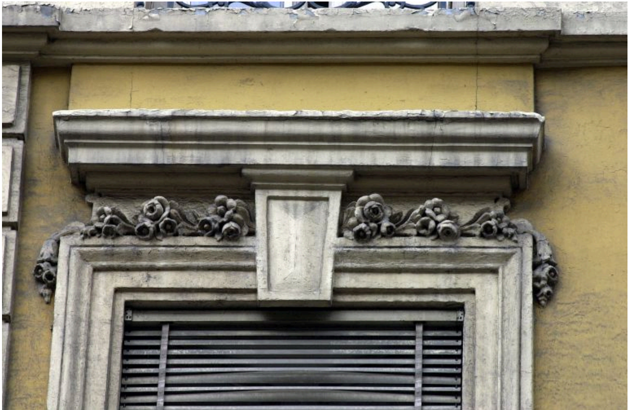
Façade principale, partie centrale, 3e niveau, détail de la fenêtre de gauche
