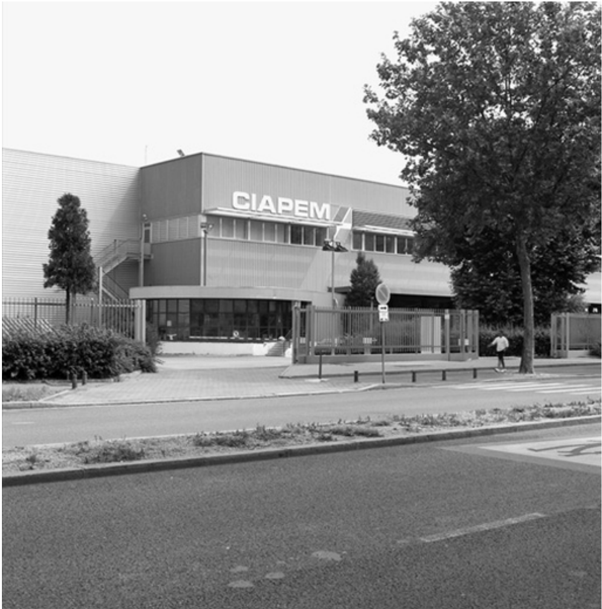
Nouvelle entrée, sud, rue Challemel Lacour
